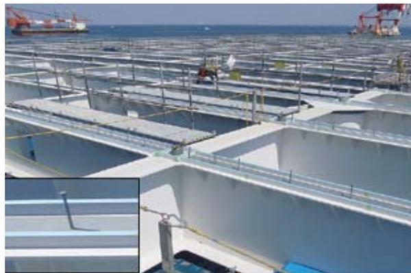
写真-3 沓座モルタル用型枠設置
