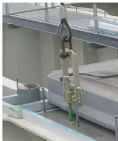
写真-4 専用吊治具
