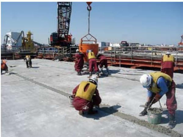
写真-6 目地コンクリート打設
