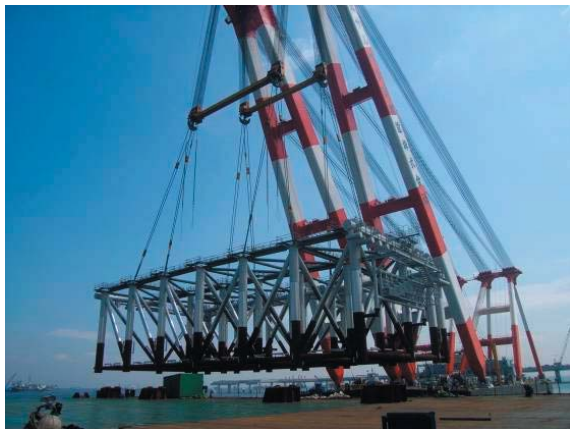
図-9 L8ジャケット水切り状況
