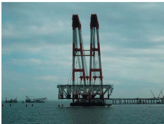
図-10 L8ジャケット据付け状況
