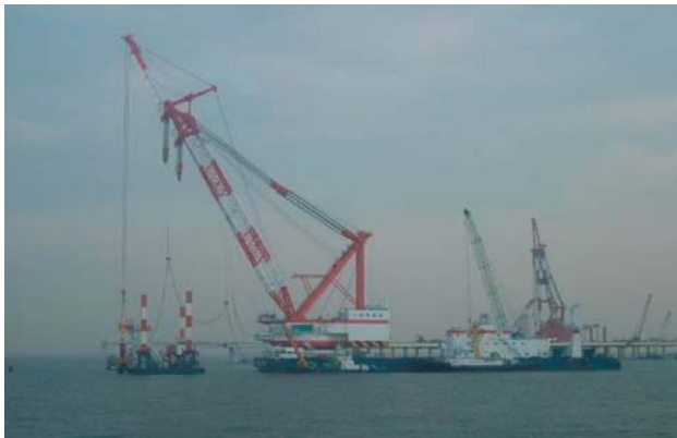
図-7 先行杭打設状況
