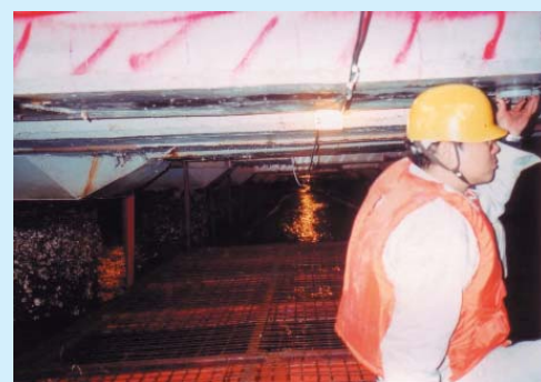
写真2 足場を用いた栈橋上部工の点検診断状況
