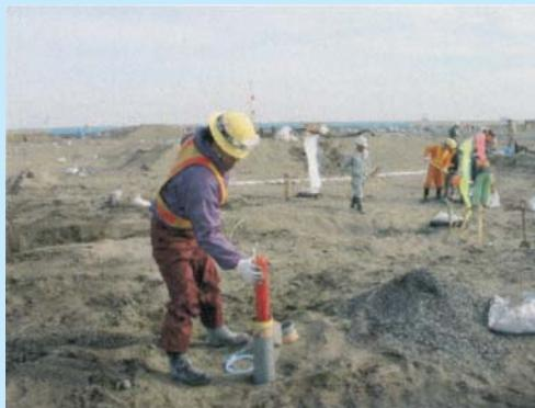
写真1 装薬作業状況(鉛直削孔発破)
