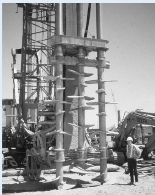
図-3 アメリカでの深層混合処理工機械(スラリー系)
