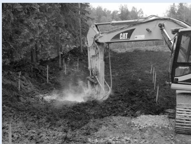
図-4 フィンランドでのMass Stabilization 工法
