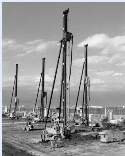
図-1 日本の深層混合処理工法（スラリー系）
