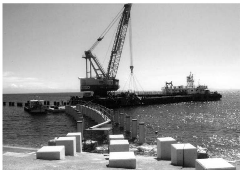
250t起重機船（第八たかし）船団による透過型有脚式突堤工事（床版据付作業）
