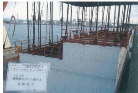
(写真4-7 吊治具取付完了状況)
