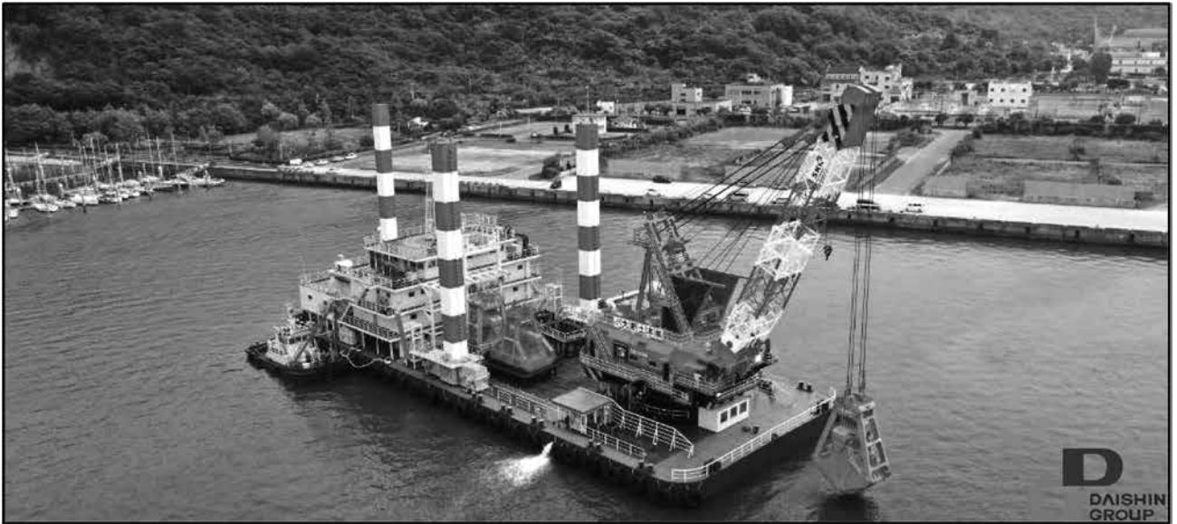
写真-1 「第01大新号」 全景
