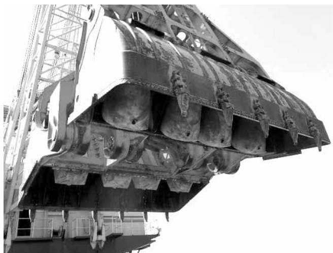
写真－６．バルーン施工状況
