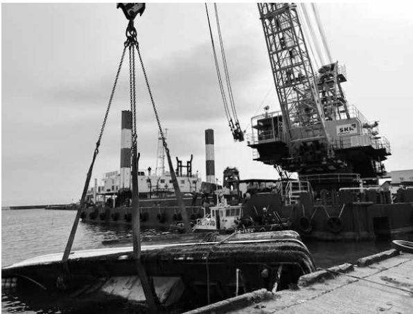
写真-7 漁船吊上げ状況
