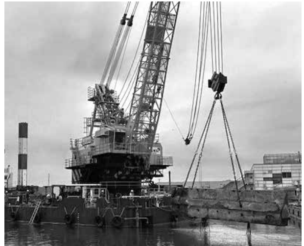
写真-8 防波堤ブロック吊上げ状況
