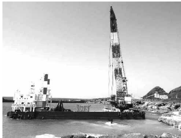
写真-3 小宝島港(鹿児島県十島村)泊地の砕岩浚渫
