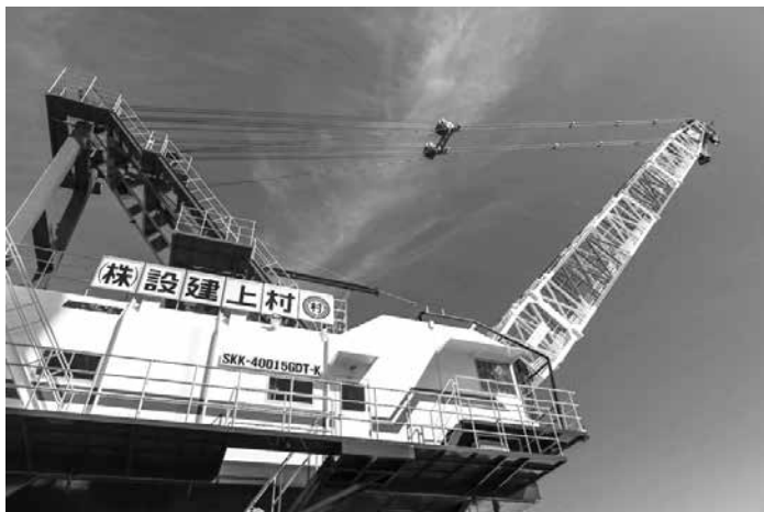
写真-1 クレーン全景
