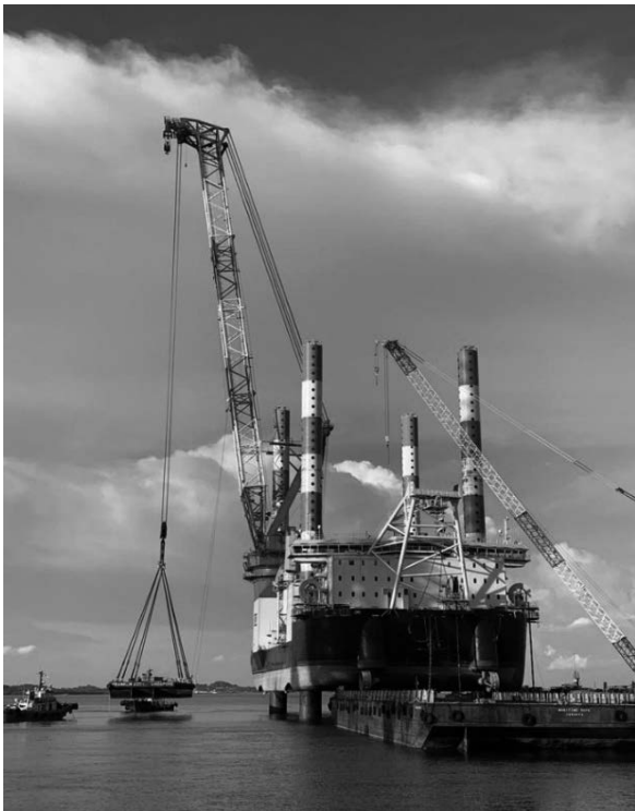
写真 メインクレーンの荷重試験
