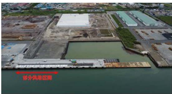
写真-4 部分供用開始時点の整備状況(令和4年7月)
