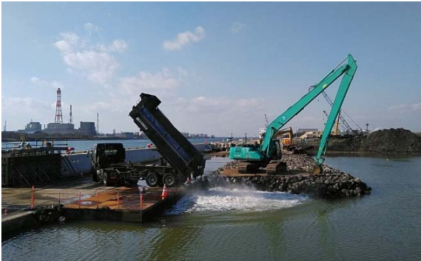
写真-9 3Dマシンガイダンスを用いた裏込石均し状況
