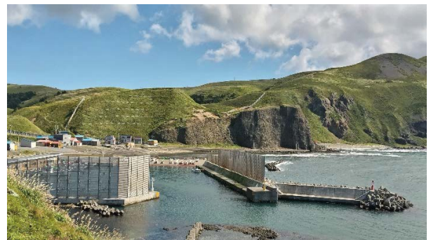
防風柵に囲まれた島内の漁港
