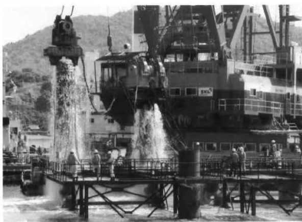
大分県佐賀関漁港 ロックバイプロ工法（2本同時打設）
