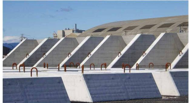
写真-12 防波堤(沖)プレキャスト上部工
