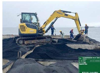
写真-8 中詰材(銅ガラミ)投入・均し
