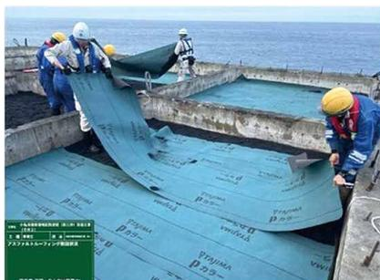
写真-9 アスファルトルーフィング敷設
