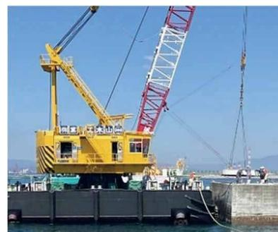
写真-10 蓋コン(プレキャスト)積出し・設置
