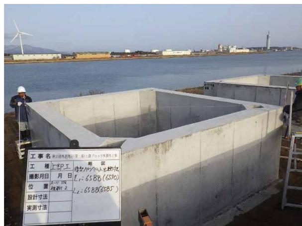
写真-6 現場製作のセルラーブロック
