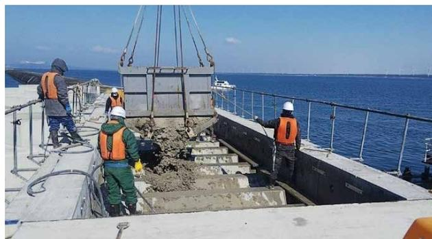
写真-5 プレキャスト施工(中詰コン打設)
