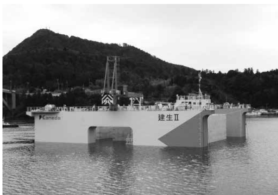
写真-7 ケーソン進水
