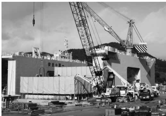
写真-5 ケーソン製作 コンクリート打設
