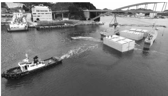
写真-8 ケーソン進水、引出し
