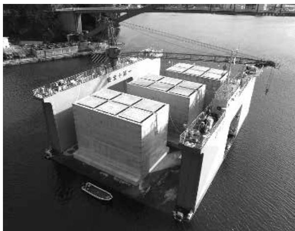
写真-2 ケーソン3函 同時製作
