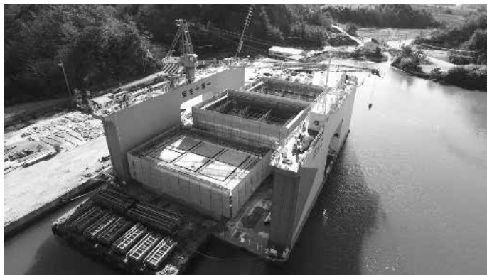
写真-6 ケーソン製作 全景
