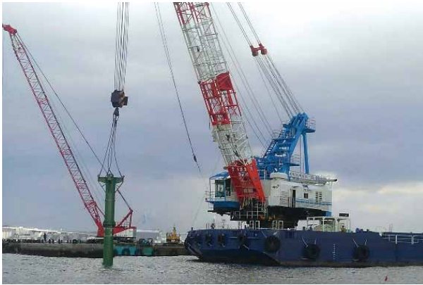
図-10 捨石均し船の施工状況
