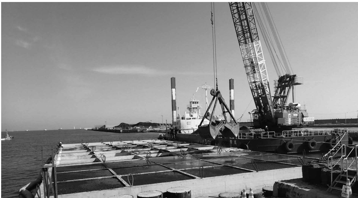
写真-8 中詰材投入作業
