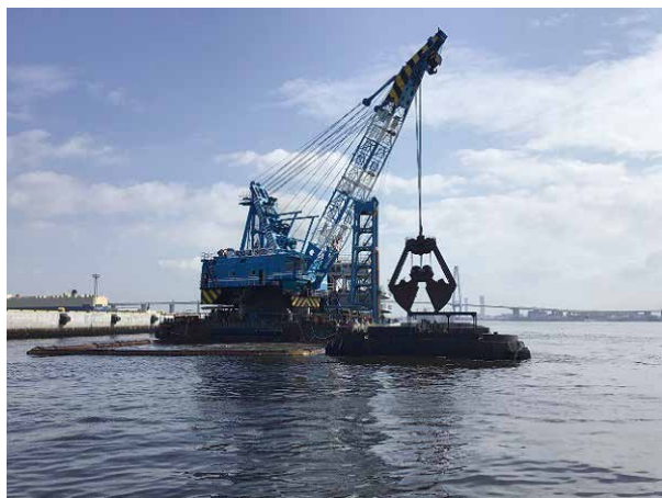
図-4 泊地浚渫状況(金剛)
