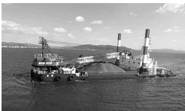
写真-2 コーミングを設置しての資材運搬
