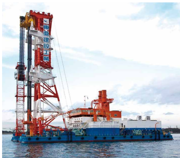
図-5 深層混合処理船
