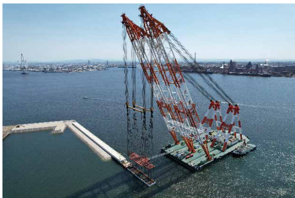
図-3 ケーソン据付状況(海翔)
