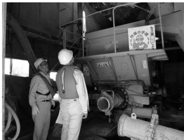
コンクリートプラントの状況確認
