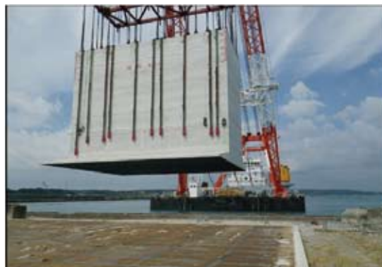
②ケーソン積込み状況1 (御前崎港)
