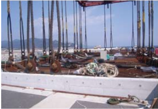
⑥締切り直前の据付け状況
