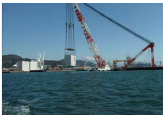
④ケーソン積卸し状況 (左は清水港製作の2函)
