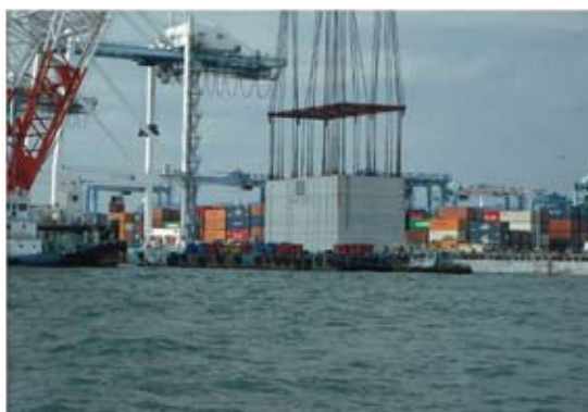
⑤ケーソン据付け状況
