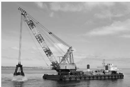
平良港において浚渫工事
