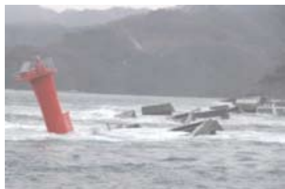
金石港湾口防波堤
