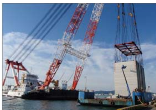
③ケーソン積込み状況2 (御前崎港)
